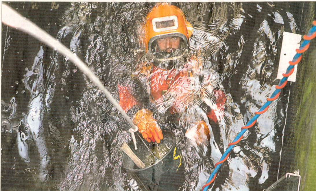
Tauchen, wo andere nicht mal schwimmen: Es geht abwärts in den Kanal des Aschaffener Klärwerks.
